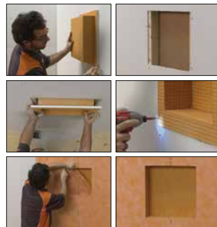
Einbau in Gipskarton
