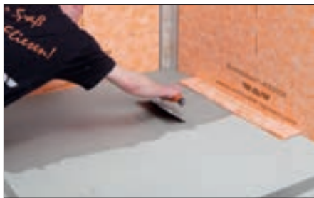
10 Estrichfläche mit Dünnbettmörtel versehen, Zahnungsempfehlung 3 x 3 mm oder 4 x 4 mm.
