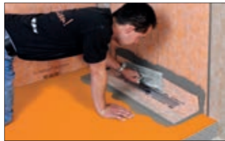
12 Schlüter-KERDI Manschette mit Schlüter-KERDI-COLL-L verkleben. Wand- und Bodenanschlüsse sind mit Schlüter-KEBA ebenfalls mit KERDI-COLL-L dicht zu verkleben.
