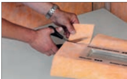
1 Schlüter-KERDI Manschette für den Eckbereich zuschneiden.
