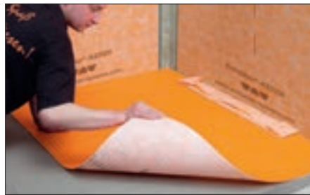
11 Schlüter-DITRA 25 aufkleben – Stöße sind mit Schlüter-KEBA unter Verwendung von Schlüter-KERDI-COLL-L abzdichten (siehe Produktdatenblatt 6.1).
